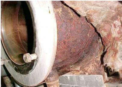
Figura 6. Corrosión bajo aislamiento.
